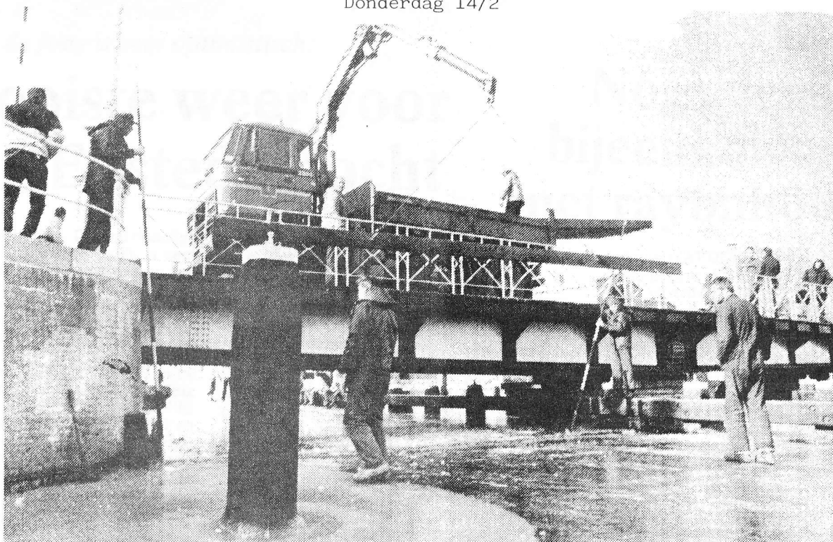
Met behulp van een takelwagen worden de schermen in het kanaal geplaatst, nadat een spleet in het ijs gezaagd is.
